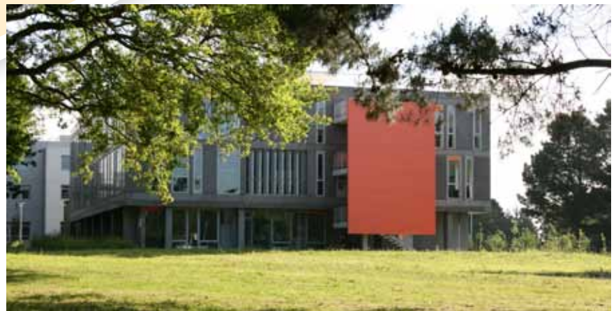
Vue arrière de la MSH (depuis arrêt Lakanal)
